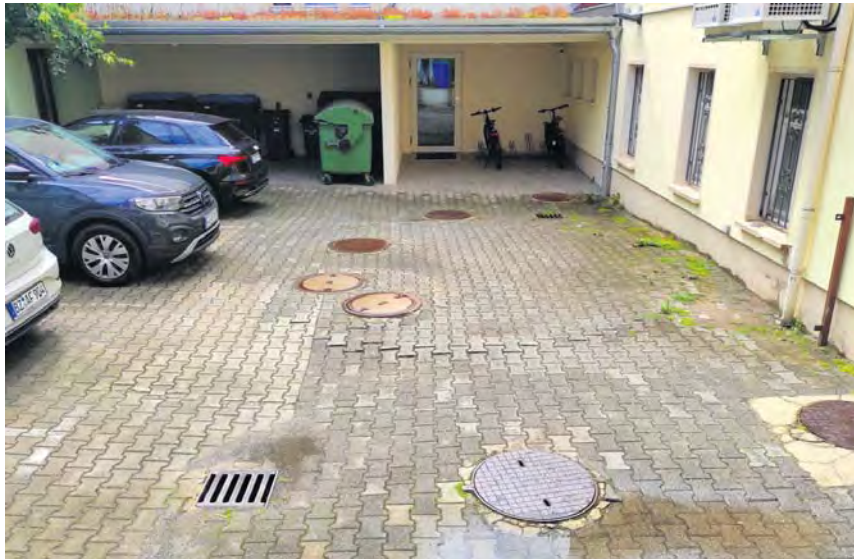
Neun von 17 Schachtabdeckungen bzw. Straßeneinläufen befinden sich auf diesem ca. 25 qm großen Teilstück des Rathausinnenhofs (Foto: M. Eckardt)
