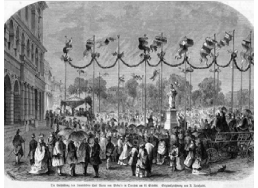
Stich von der Einweihungsfeier des Weber-Denkmal in Dresden vor 150 Jahren
