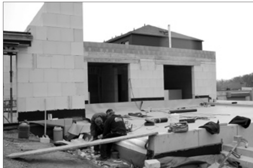
Für die Terrasse am Sport- und Freizeitzentrum Oberlichtenau dichten die Dachdecker das Sockelgeschoss ab. Daneben führt die Betontreppe nach unten.
