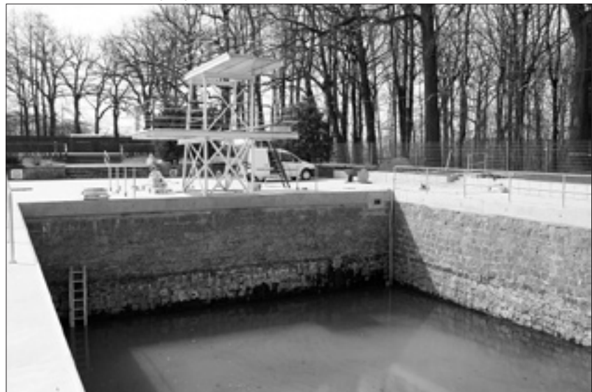
Noch steigt der Wasserstand langsam in der Sprunggrube bis 14. Mai.
