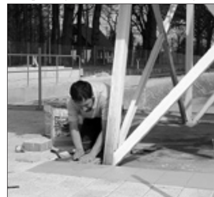
Letzte Arbeiten: unter dem Sprungturm wird neu gefliest.
