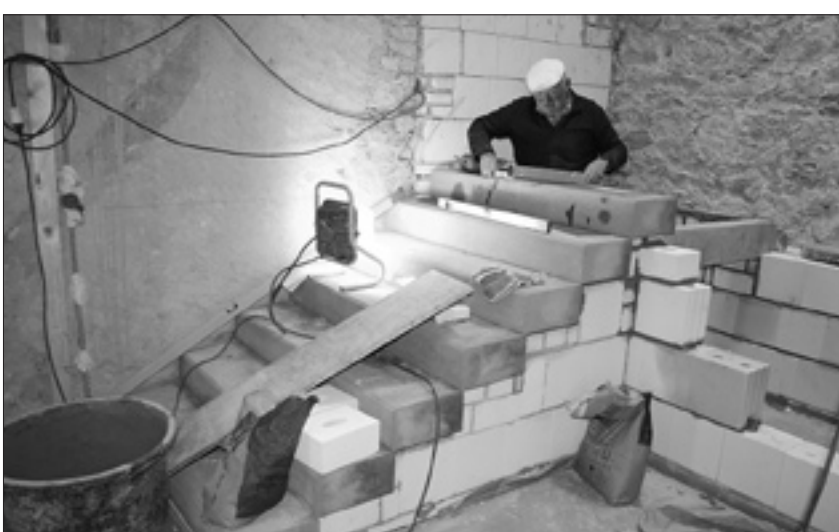
Auf dieser Baustelle sind die Grundinstallationen für Elektro/Heizung/Sanitär bereits erfolgt und der Estrich ist eingebaut worden. Nun laufen die Arbeiten an der Außenfassade und beim Einbau der Treppe. Alle drei Pulsnitzer Baustellen liegen im Zeitplan.
