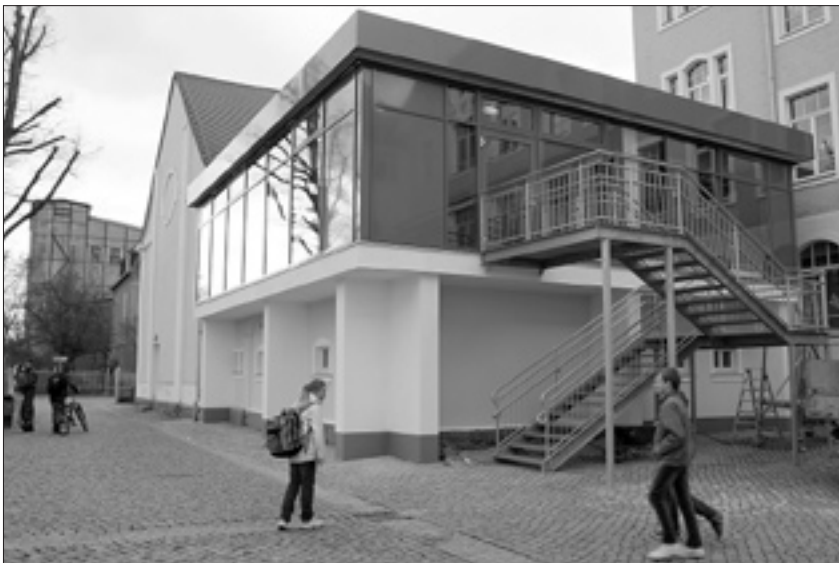
Die Übergabe erfolgte planmäßig am 12. April. Der restlichen Arbeiten an der Außenfassade werden bis Ende April noch fertiggestellt.
