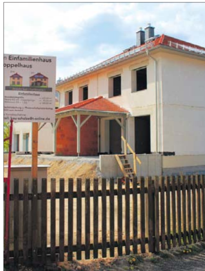
Neubau in der Pulsnitzer Feldstraße (Foto: M. Eckardt)
