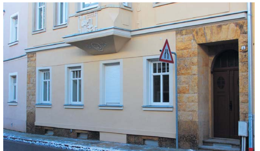
und nach der Sanierung (2023) (Fotos: E. Rietschel/M. Eckardt)
