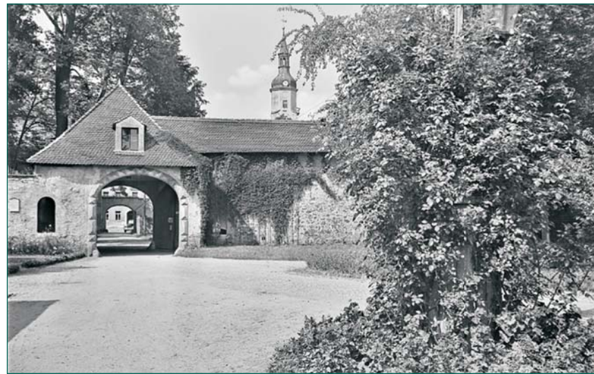
Hier ist noch die Öffnung in der Mauer zu erkennen.
