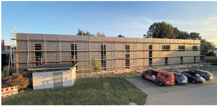
Die neue Logistikhalle entsteht
