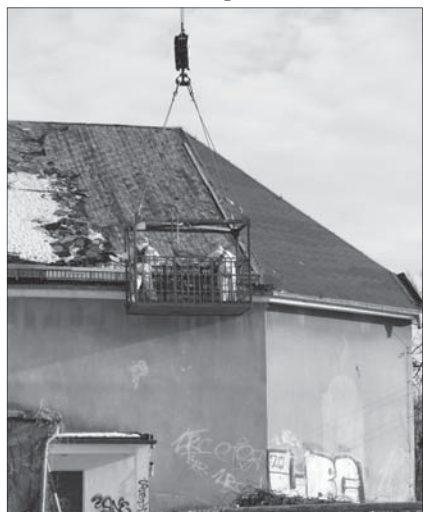
Abbruch des Asbestdaches der Kante.
