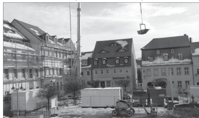
Abbruch des Dachstuhls am Rathaus. Das Material bringt ein Kran nach unten zu den Containern auf dem Markt.
