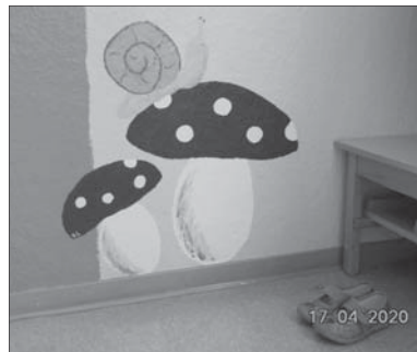
Blick auf die neuen Wände in der Garderobe.
