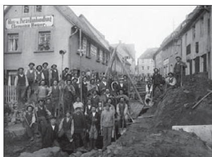
Bauarbeiter auf der Schlossstraße
