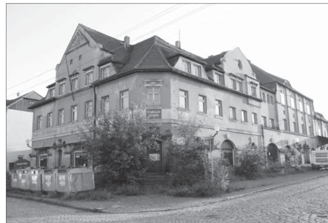
Der Konsumkomplex vor dem Beginn der Renovierung.
