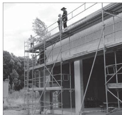
Zimmermann und Bürgermeisterin beim Richtspruch
