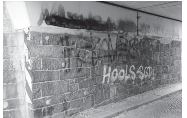
Bahnbrücke über die Feldstraße.
