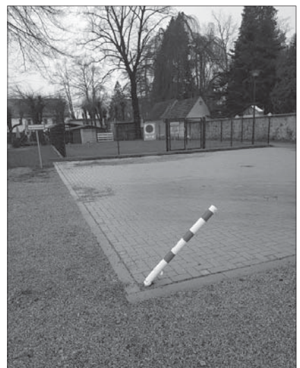
Umgebogener Poller am Feuerwehrstellplatz auf dem Schützenplatz.
