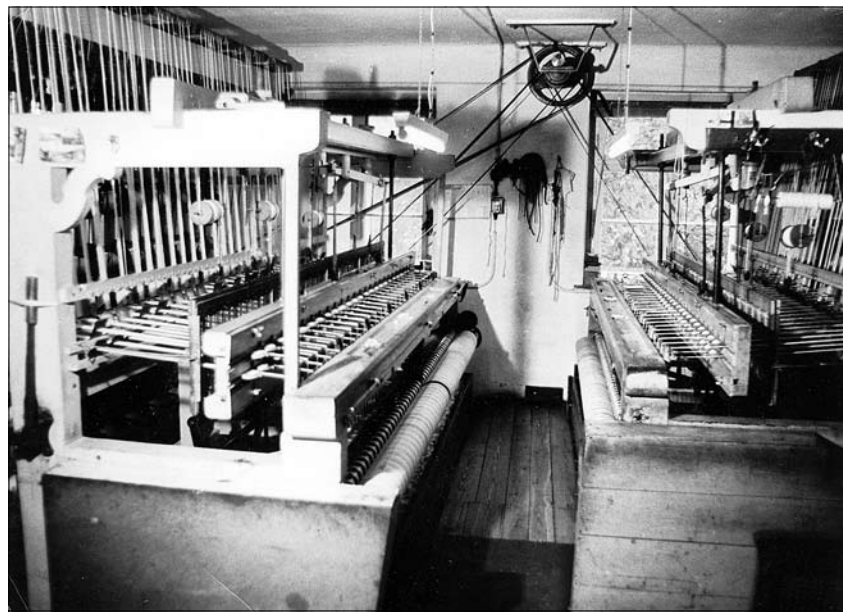
Heimbandweberei von Fam. Bulling (ca. 1980), heute Königsbrücker Str. 142 Zwei „Preller“ Webstühle mit Transmissionsantrieb Auf diesen Bandwebstühlen hat schon 1935 der spätere Friedersdorfer Bürgermeister Willi Kühne (Vater von Lieselotte Bulling) gewebt.
