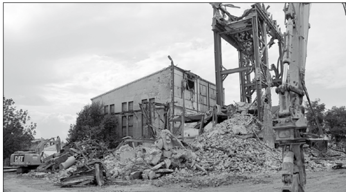
Abriss Maschinen- und Kesselhaus des ehemaligen E-Werkes
