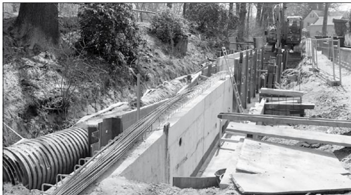
Bau Ufermauer an der Schulstraße
