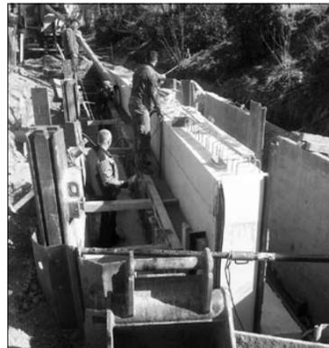
**Ufermauer: Vorbereitungsarbeiten für die Abdeckungskappen**
