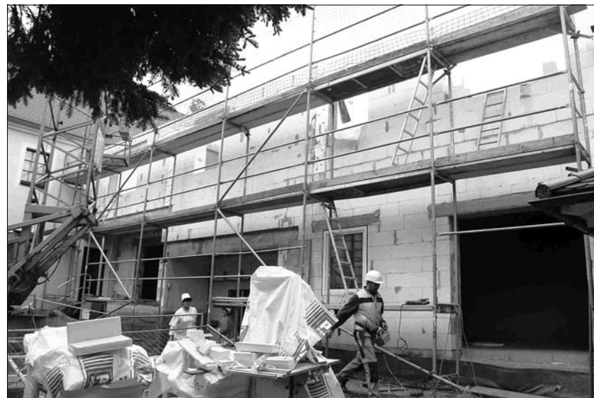
Mittlerweile sind am Neubau die Gerüste gefallen, die Zufahrt asphaltiert und in der Backstube herrscht saisonaler Hochbetrieb. Die Bauarbeiten ruhen und werden Anfang nächsten Jahres beendet.
