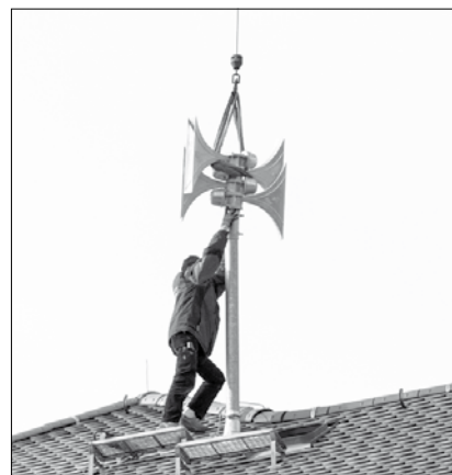
Montage der Sirene Foto: Sielaff Standrohr. Für die Neuerrichtung der Sirene auf dem Dach der Pulsnitzer Oberschule wurden insgesamt 8.550 Euro ausgegeben. An dem neuen Standort waren zusätzlich Arbeiten zur Statik, Zimmermannsarbeiten und ein neuer Stromanschluss für die Sirene notwendig.
