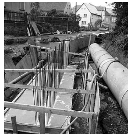
Die Bauarbeiten haben die Brücke an der alten Schule erreicht.
