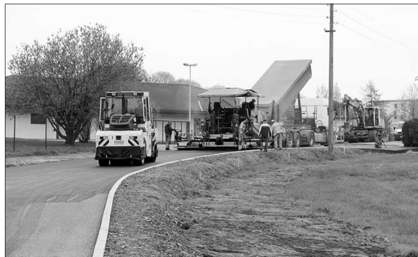
Asphalteinbau auf der Mittelbacher Straße am 30. April
