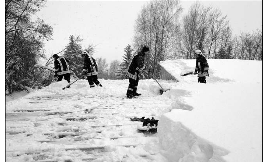
Die Kameraden befreien das Dach der Sporthalle Hempelstraße von den Schneemassen. (Fotos: Sielaff)
