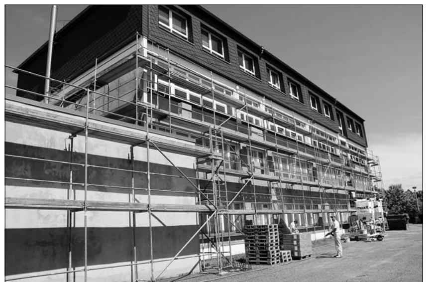
Juli-September: Einbau neuer Fenster und Fassadendämmung Keulenbergstraße 6, Grundschule Oberlichtenau
