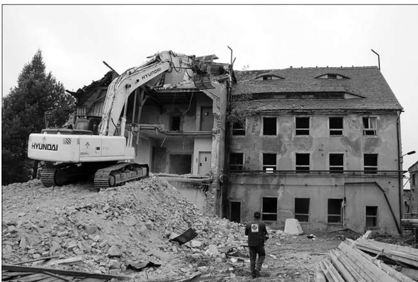
Mai: Abriss Herrenmode auf der Grünen Straße, ab September Renaturierung des Areals
