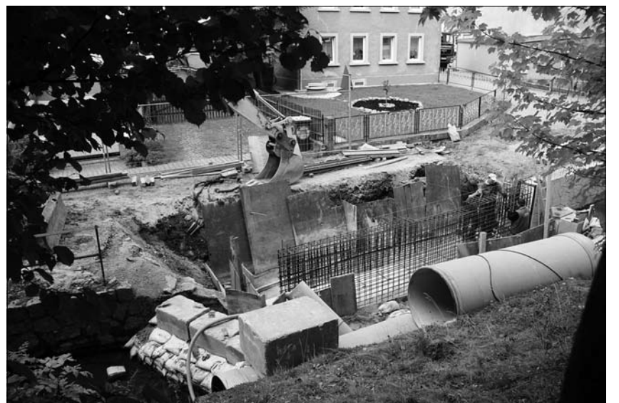
23. Juli: Beginn Bau Ufermauer an der Schulstraße
