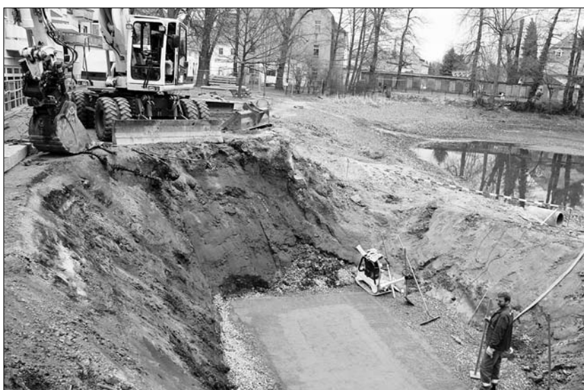
Am Schlossteich gingen erst am 19. März die Arbeiten weiter. Der Bootsanleger auf der anderen Teichseite ist bereits vollständig erneuert.
