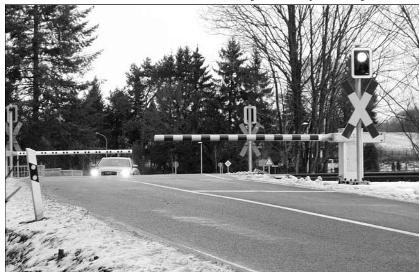
So sieht der neue Bahnübergang am km 14,1 an der Großröhrsdorfer Straße aus, demnächst auch an drei weiteren Übergängen in Pulsnitz.
