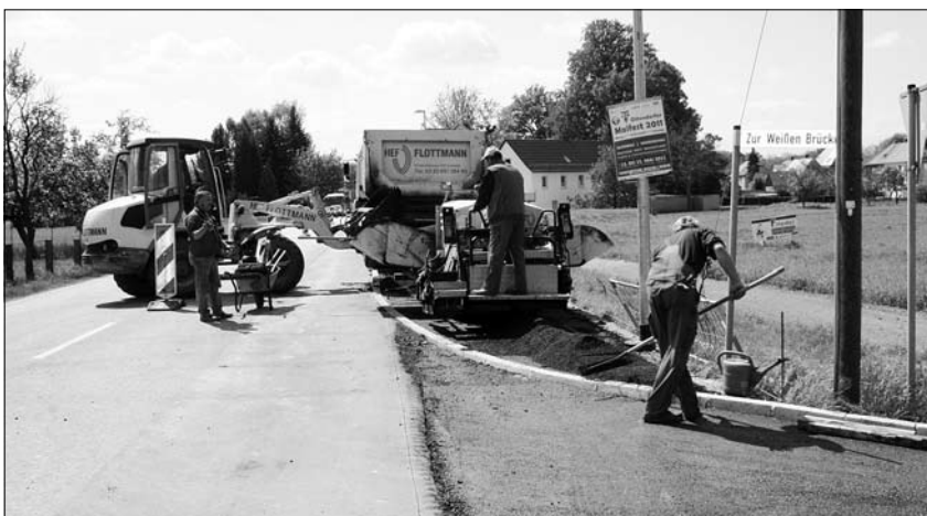
Radwegbau nach Weißbach
