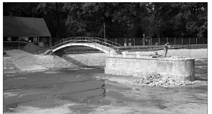
Sanierung im Walkmühlenbad geht weiter.
