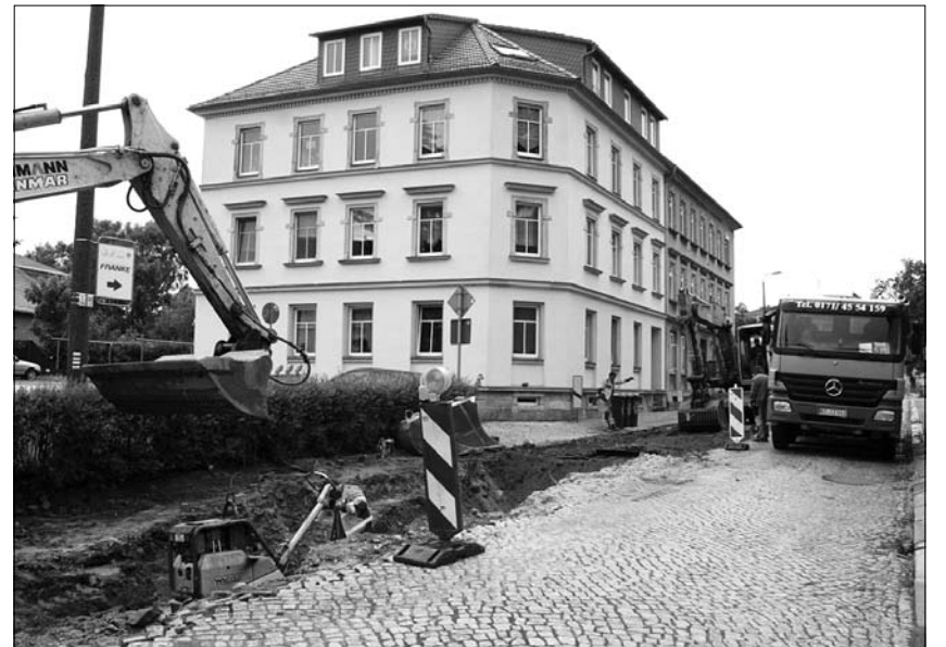
Grundhafter Ausbau der Königsbrücker Straße
