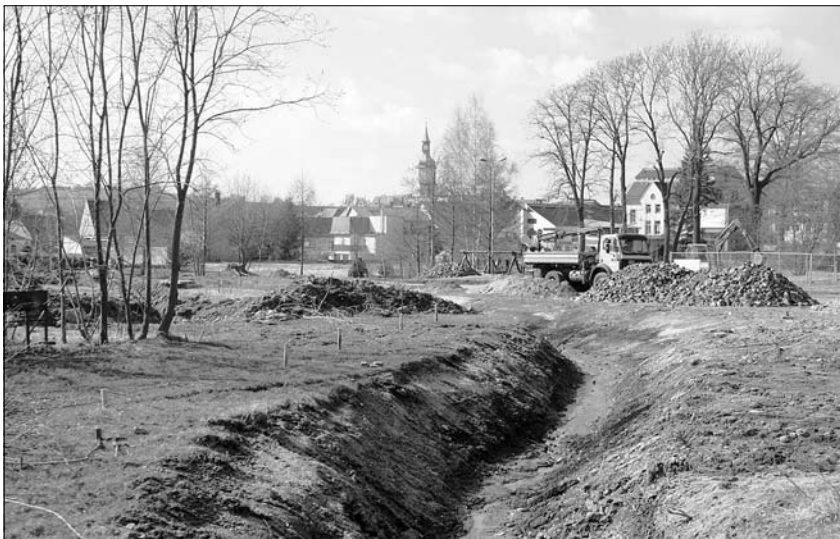
Freilegung des alten Wasserlaufes
