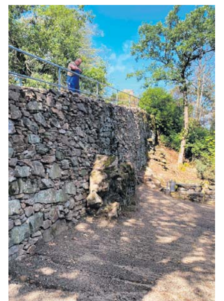
Die sanierte Trockenmauer (Foto: M. Soppa)
