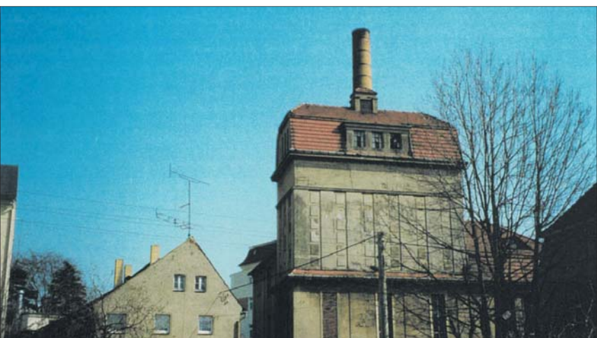
Das Firmengelände kurz vor dem Abriss des Hauptgebäudes
