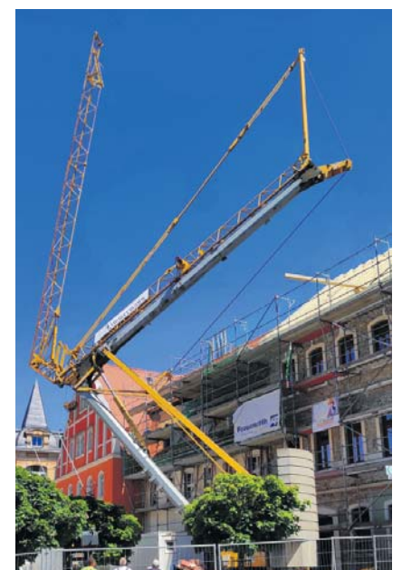
Seit 15. Juni ist der Baukran auf dem Marktplatz Geschichte (Foto: M. Eckardt)
