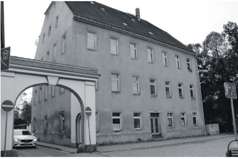
Herrenhausplatz mit Herrenhaus: links vor und rechts nach der Sanierung (Fotos: E. Rietschel)
