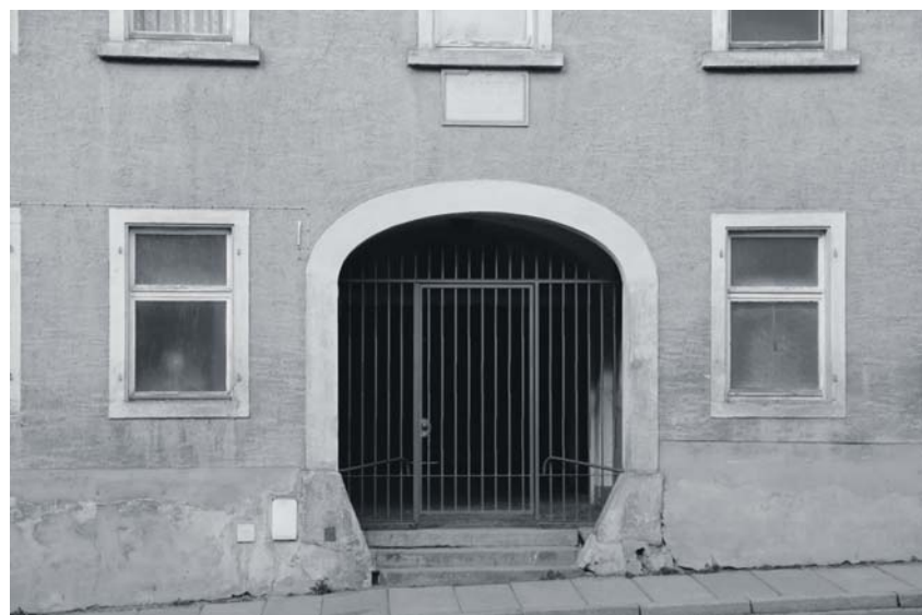
Alte Schule, Durchgang zum Kirchplatz: links vor und rechts nach der Sanierung (Fotos: E. Rietschel)
