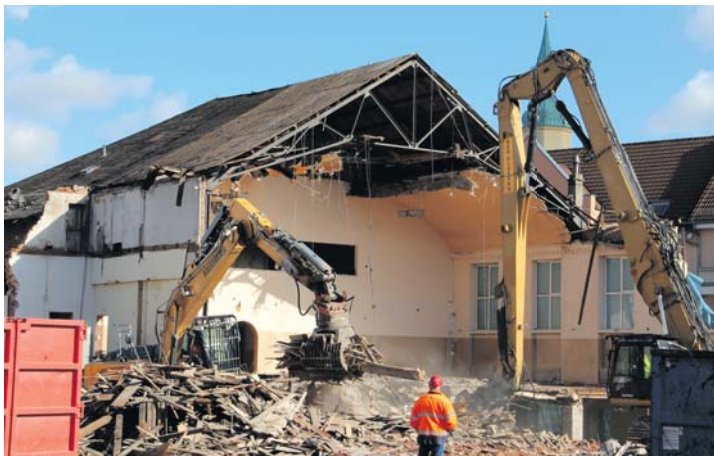
19. Februar – Am Gebäude der Kante fressen sich die Bagger durch den Saal. Beim Abriss wurde der tatsächliche Zustand des Gebäudes erst so richtig für alle offensichtlich. Akribisch werden Holz, Metall und Bauschutt getrennt.
