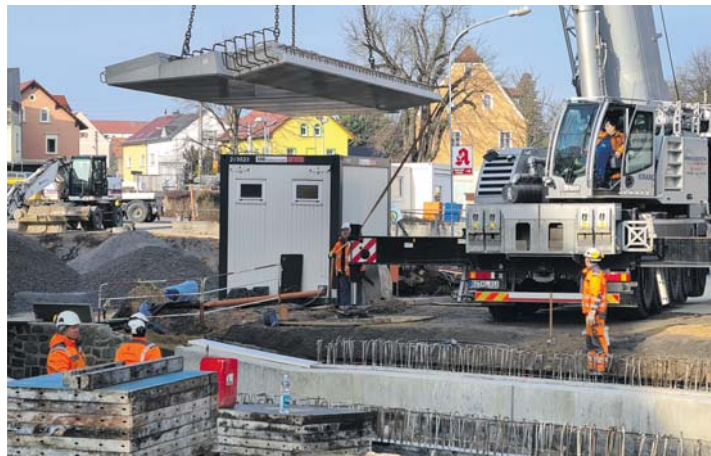
25. März – Die Betonteile schweben für den Brückenbau über die Pulsnitz an der Robert-Koch-Straße/Dresdener Straße ein. Der Bau begann am 8. Juli 2020 und die Freigabe der Straße erfolgte am 11. August 2021.
