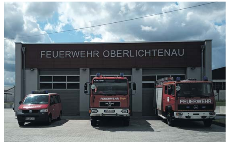
18. Juli – Mit einem Tag der offenen Tür und entsprechend großer Beteiligung konnte die Übergabe des neuen Feuerwehrgeräte- hauses an die Oberlichtenauer Kameraden erfolgen und ausgiebig gefeiert werden.
