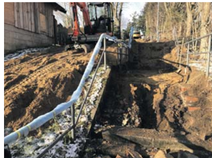
Sanierung der Treppe zur Schule.
