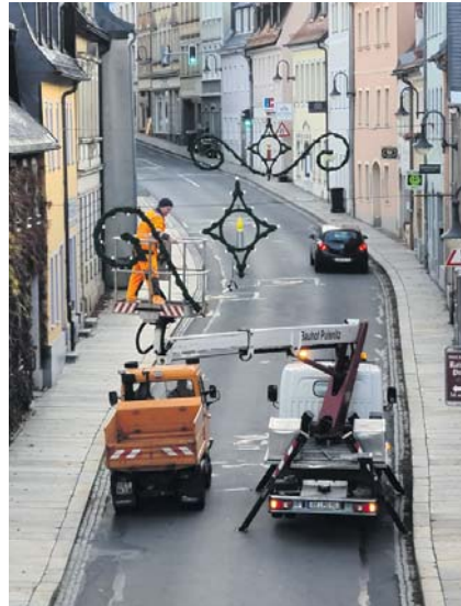
Unser Bauhof bei der Installation der Weihnachtsbeleuchtung in der Innenstadt.
