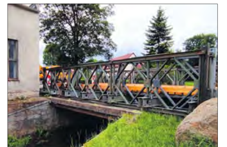
tengründen für eine Massivbauvariante ausgesprochen. Die entsprechenden Planungen laufen bereits, bis Ende November ist mit deren Abschluss zu rechnen. Unter der Voraussetzung, dass die notwendigen Fördermittel bewilligt werden, ist die Bauausführung für das Jahr 2025 vorgesehen. (Foto: M. Eckardt) ME
